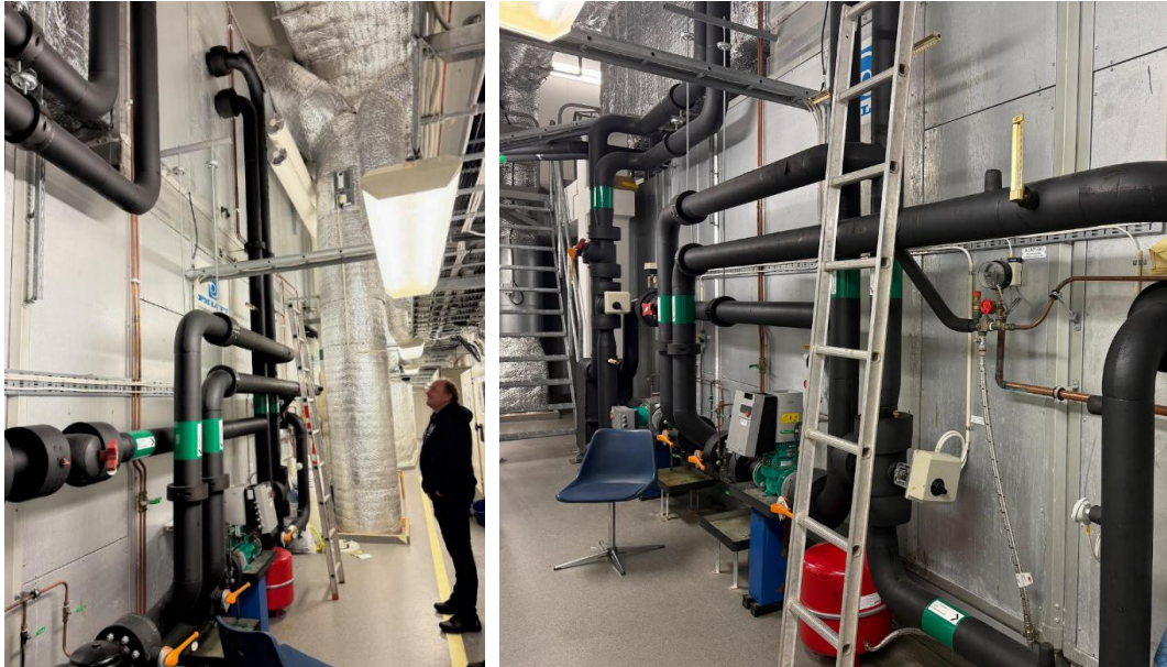
Figur 5 Behovsstyrt VKVÅ-aggregat med kapacitet upp till 18 m 3 /s.
