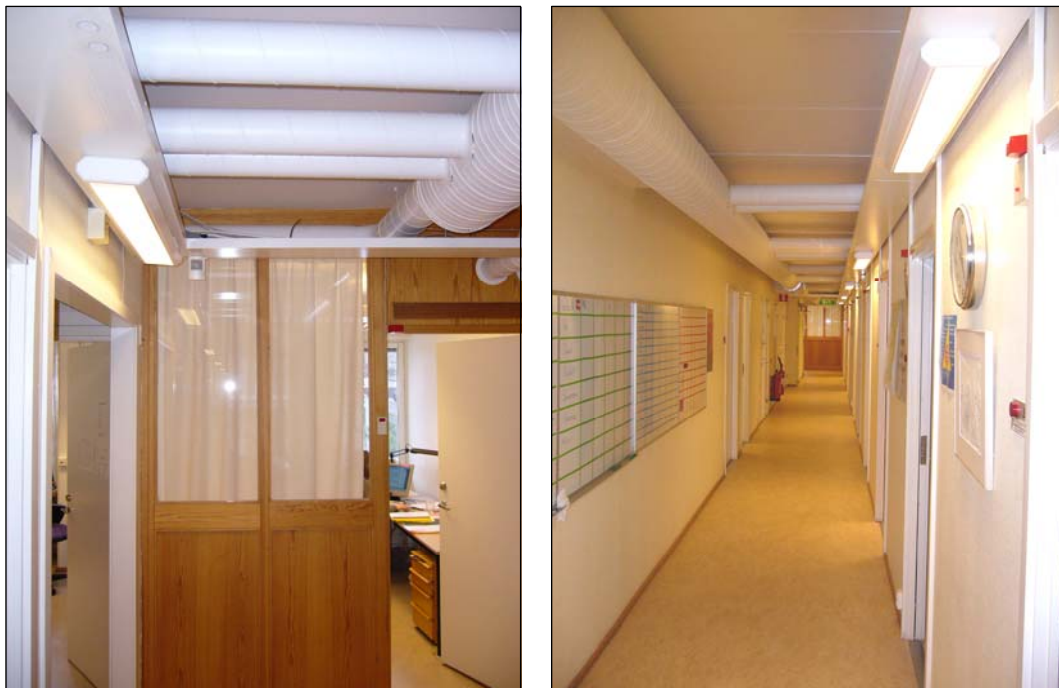
Figur 1 Fotografierna visar den nya belysningen. En närvarogivare för belysningsstyrningen skymtar på vänstra fotot, i armaturens förlängning.
