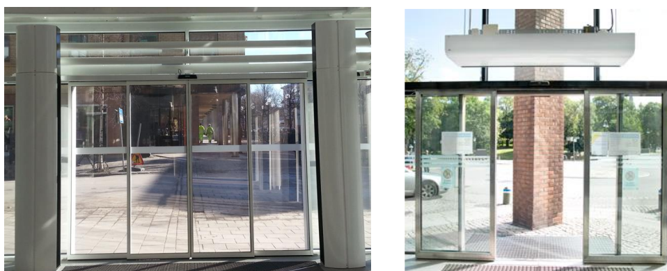
Figur 3 Exempel på horisontell respektive vertikala luftridåer i butik. Källa: www.frico.net
