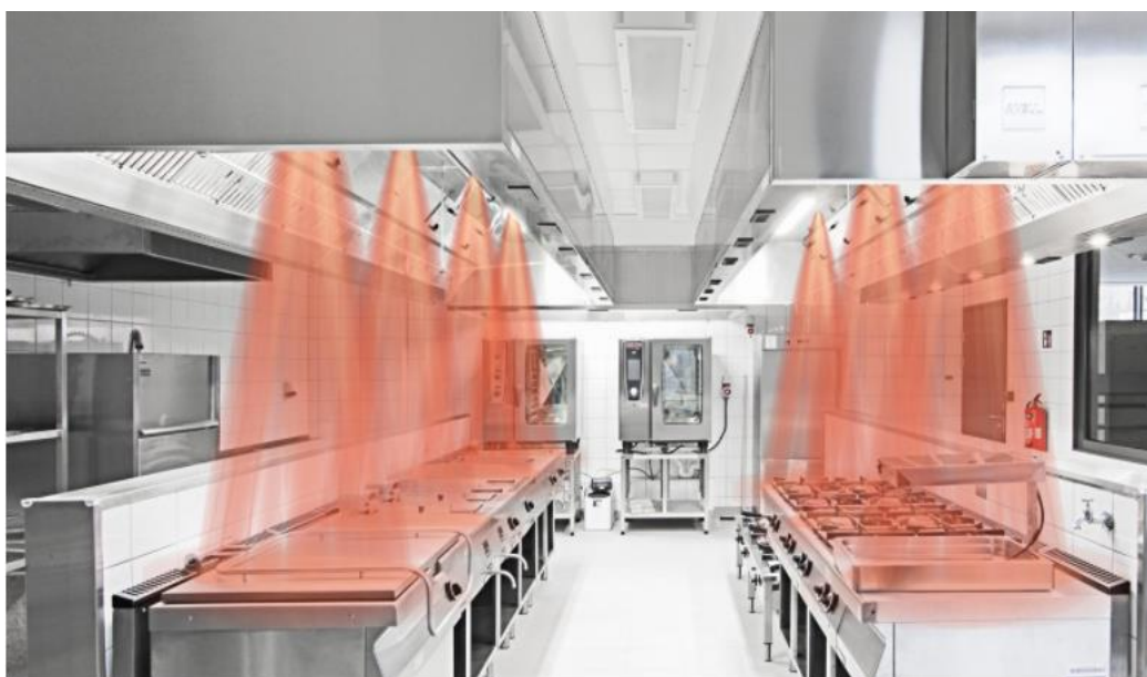
Figur 2. Principbild över Haltons behovsstyrning med IR-sensorer.
