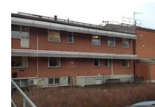
TANKEN 9 (Hälsö AB) Projekt 11 mars 2013 Fastighet på 3160 m 2 Åtemp som rymmer kontor, lager samt verkstad. Totalt energibehov (värme samt el) per år före åtgärder: 185 kWh/m 2 Beräknat totalt energibehov per år efter... Läs mer >
