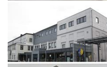
BYGGNAD 74 (TROLLHÄTTANS TOMT AB) Projekt 3 oktober 2014 Fastighet på 3 667 m 2 Åtemp med kontorshotell, turistbyrå och konferensanläggning. Totalt specifikt energibehov (värme samt el) per år före åtgärder: 156 kWh/m 2 Beräknat totalt specifikt energibehov... Läs mer >
